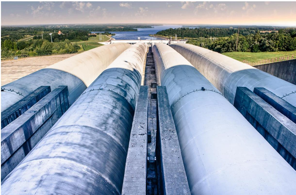
Bei einem Stromüberschuss wird Wasser aus dem unteren in das obere Becken gepumpt.
